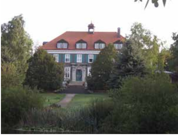
Hotel Gutshof Stellshagen heats using the HDG Compact 200
